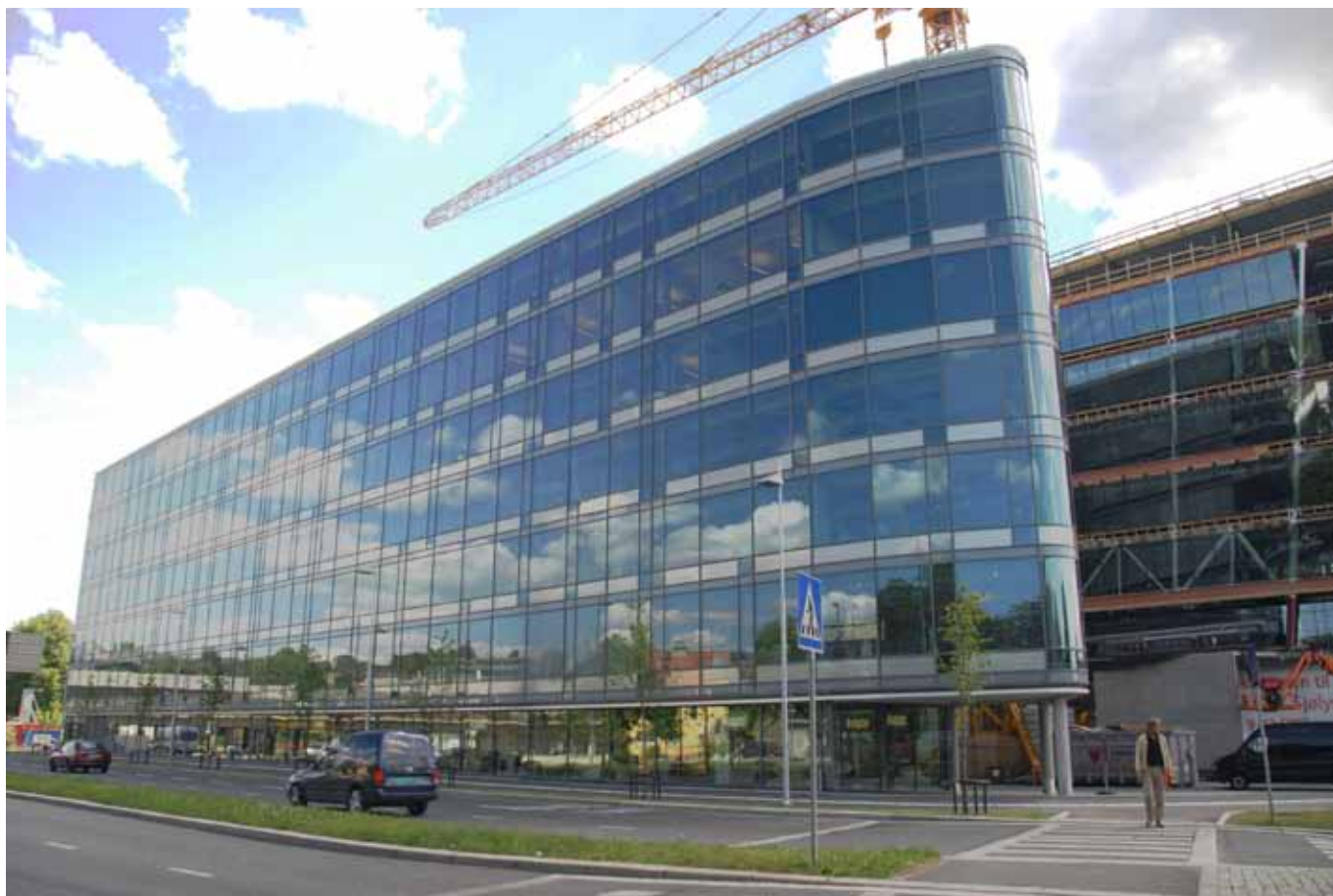
FRAM-bygg på Skøyen i Oslo
